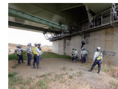
橋梁点検現場勉強会
