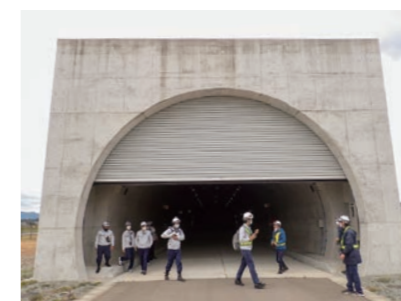
トンネル点検現場勉強会 (福島テストフィールドにて)
